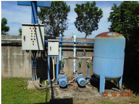
ภาพที่ 2-57 ระบบปั๊มน้ำจากบ่อพักน้ำทิ้งมารดน้ำต้นไม้ ในพื้นที่โรงไฟฟ้า
