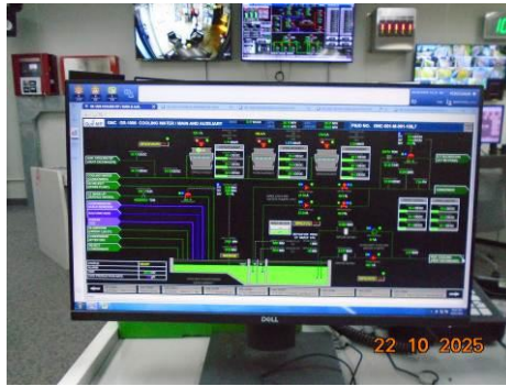
ภาพที่ 2-15 ระบบควบคุมอุณหภูมิของน้ำทิ้งที่ผ่านหอหล่อเย็น
