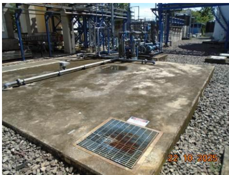
ภาพที่ 2-20 บ่อปรับสภาพความเป็นกรด-ด่าง (Neutralization Pit)
