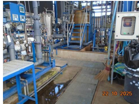
ภาพที่ 2-54 รางระบายบริเวณสถานที่เก็บสารเคมีอันตราย
