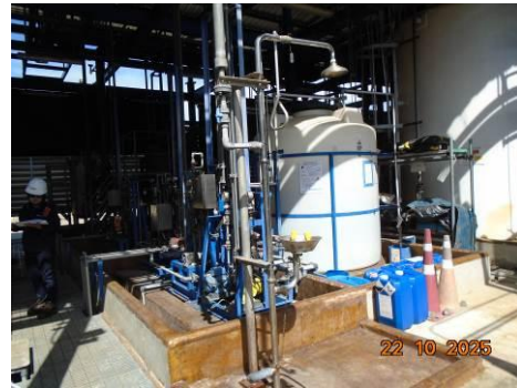
ภาพที่ 2-52 Emergency Eye Shower and Washer
