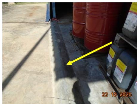
ภาพที่ 2-60 คันกันป้องกันการรั่วไหลของน้ำมันบริเวณอาคาร สำหรับจัดเก็บน้ำมัน
