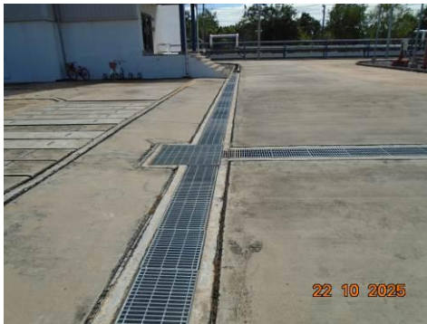
ภาพที่ 2-29 ระบบรวบรวมน้ำฝนและท่อระบายน้ำของโรงไฟฟ้า
