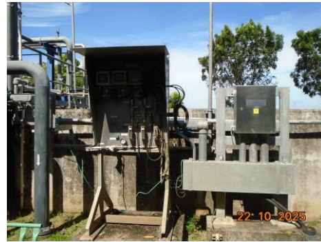
ภาพที่ 2-10 ระบบติดตามตรวจสอบคุณภาพน้ำทิ้งแบบต่อเนื่อง (Online Monitoring) บริเวณจุดระบายน้ำทิ้งของโครงการ
