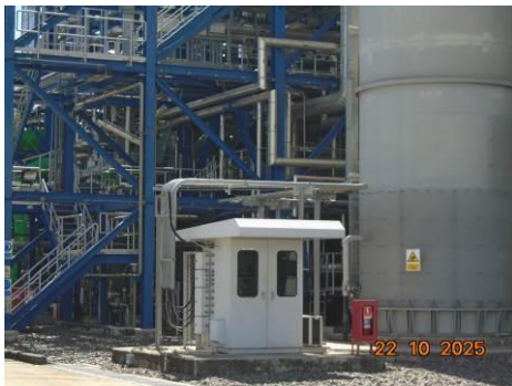
ภาพที่ 2-3 ระบบตรวจสอบคุณภาพแบบต่อเนื่อง (CEMs) ของโรงไฟฟ้า
